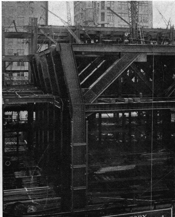
Detalle de una fila de columnas excéntricas que soportan toda la estructura
