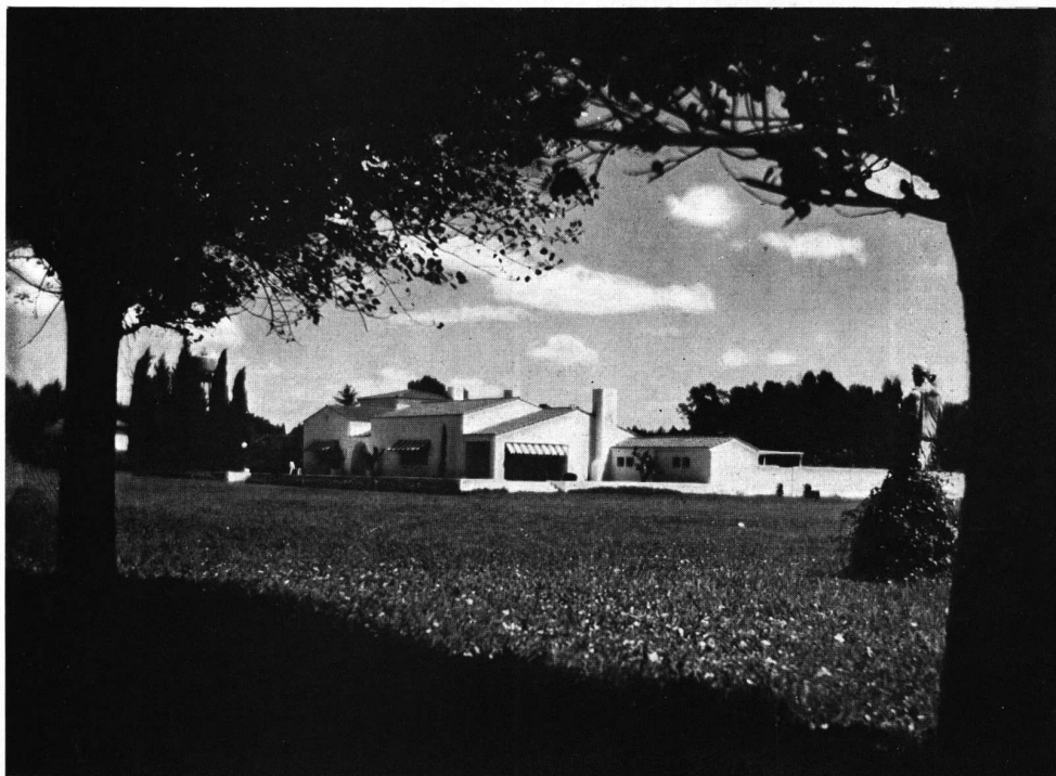
DETALLE DE LA ENTRADA Y VISTA GENERAL
