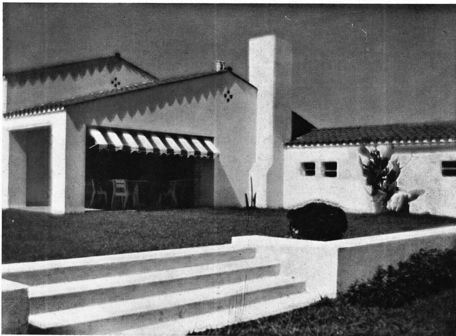
DETALLE DE FACHADA
