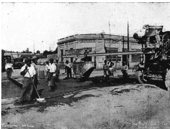
Vaciando el hormigón preparado con Incor en un cruce de calle del camino de Rivadavia a Olivos.
