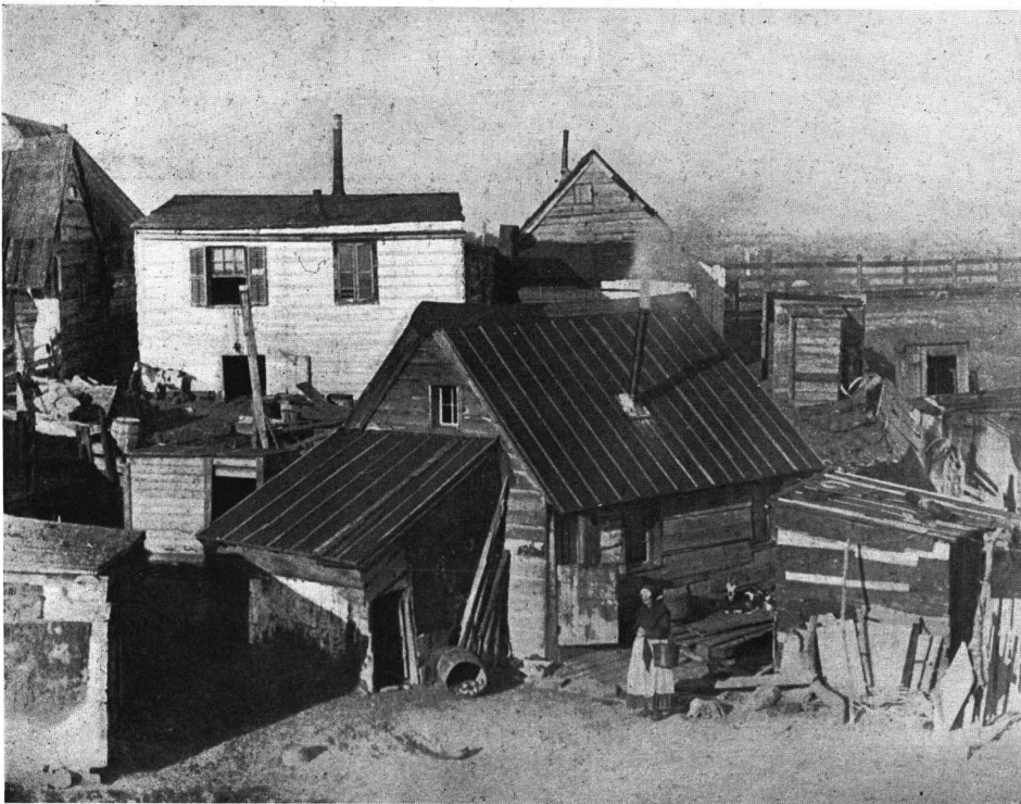
NEW YORK - Esquina 95 y Quinta Avenida en Octubre de 1888
