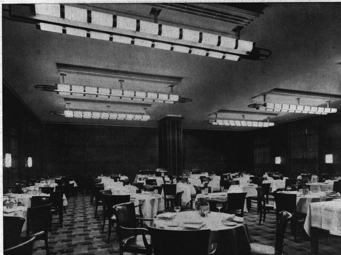
Un alumbrado sereno, distinguido y ante todo decorativo de un restaurant mediante focos semi-cilíndricos de vidrio opalino que, armados y sostenidos con partes metálicas, brindan de día una vistosa decoración del local y de noche un tipo ideal de iluminación.
