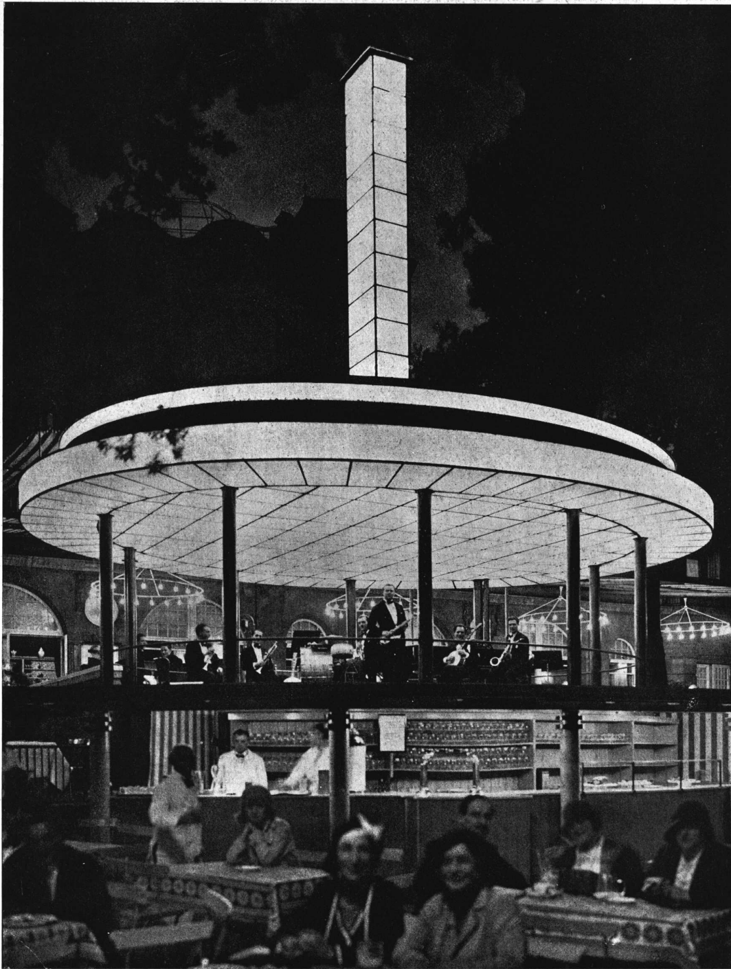
Pabellón de música de cubos luminosos, una muestra ejemplar de la arquitectura luminosa moderna. La construcción, tipo kiosko, está formada por un plano de vidrio difusor de luz con 228 lámparas eléctricas de unos 13.000 vatios en total.
