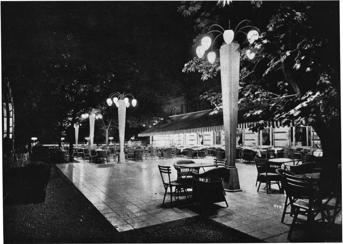
Iluminación irreprochable de un restaurant-jardín mediante columnas con focos de vidrio dispuestos en forma caprichosa que dan al jardín una luz buena y agradable, libre de todo encandilamiento.
