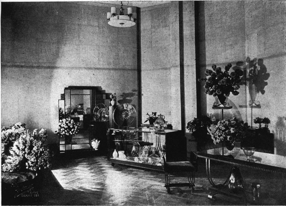
VISTA DEL NEGOCIO DE LA PLANTA BAJA
