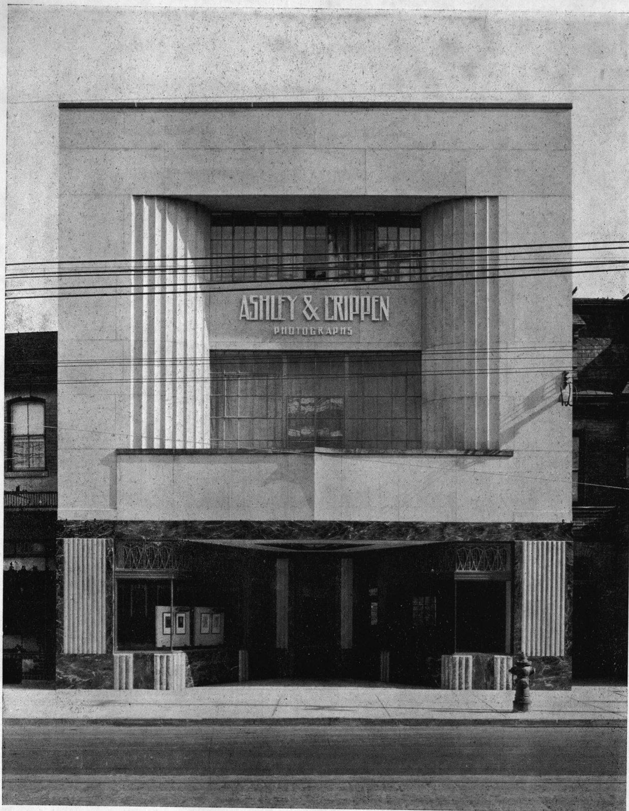
Empleos del aluminio en la parte exterior de negocios. Las partes metálicas de este frente, como plintos, cornisas, placas, herrajes y soportes de las vitrinas, son todas de aluminio.
