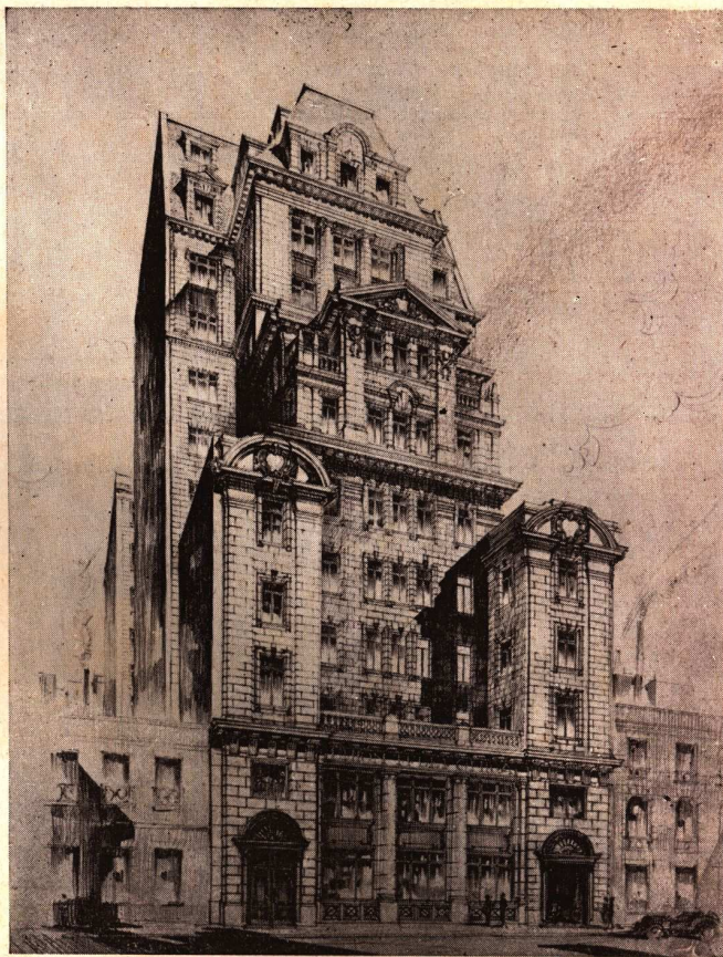
EL EDIFICIO CENTRAL DE LA COMPAÑIA UNION TELEFONICA DEFENSA 143-159 - BUENOS AIRES
