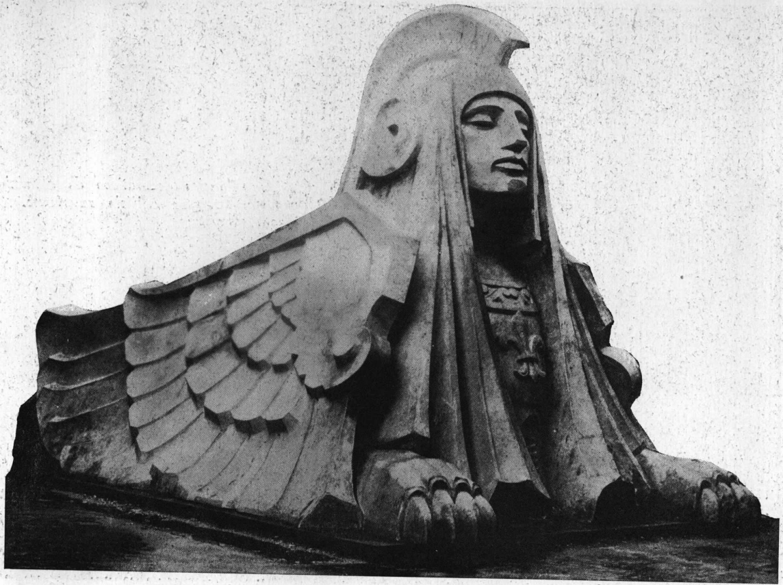
Esfinge en aluminio fundido, terminado a chorro de arena, colocado en el ápice del techo del Tribunal Civil de San Luis. Está hecha de trece piezas de aleación de aluminio y pesa aproximadamente 2,000 kilos.
