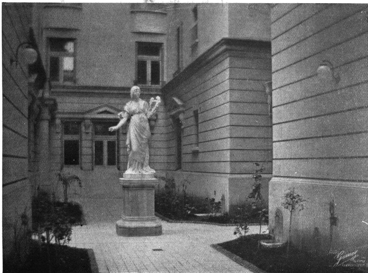
Casa de renta - San Martín 561 Propiedad de la Sra. María L. de Bellocq. DETALLE DEL PATIO Arq. JORGE BUNGE
