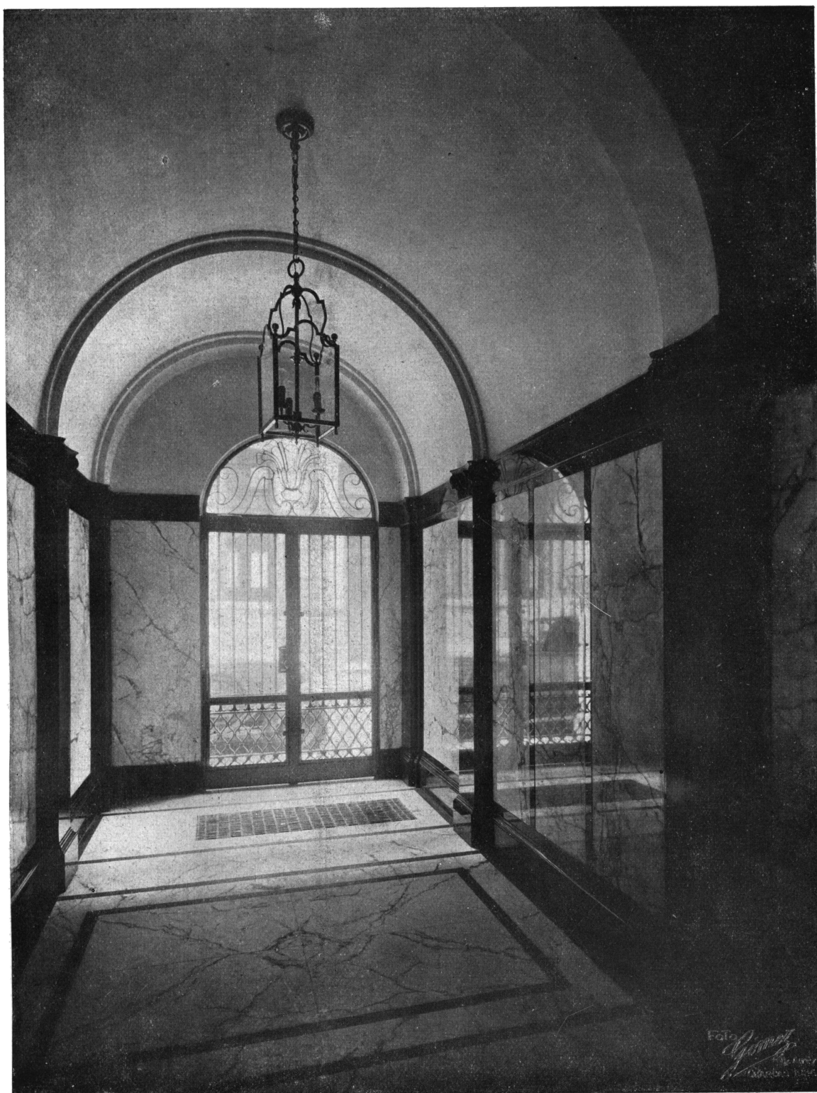
Casa de renta - San Martín 561 Propiedad de la Sra. María L. de Bellocq DETALLE DE LA ENTRADA Arq. JORGE BUNGE
