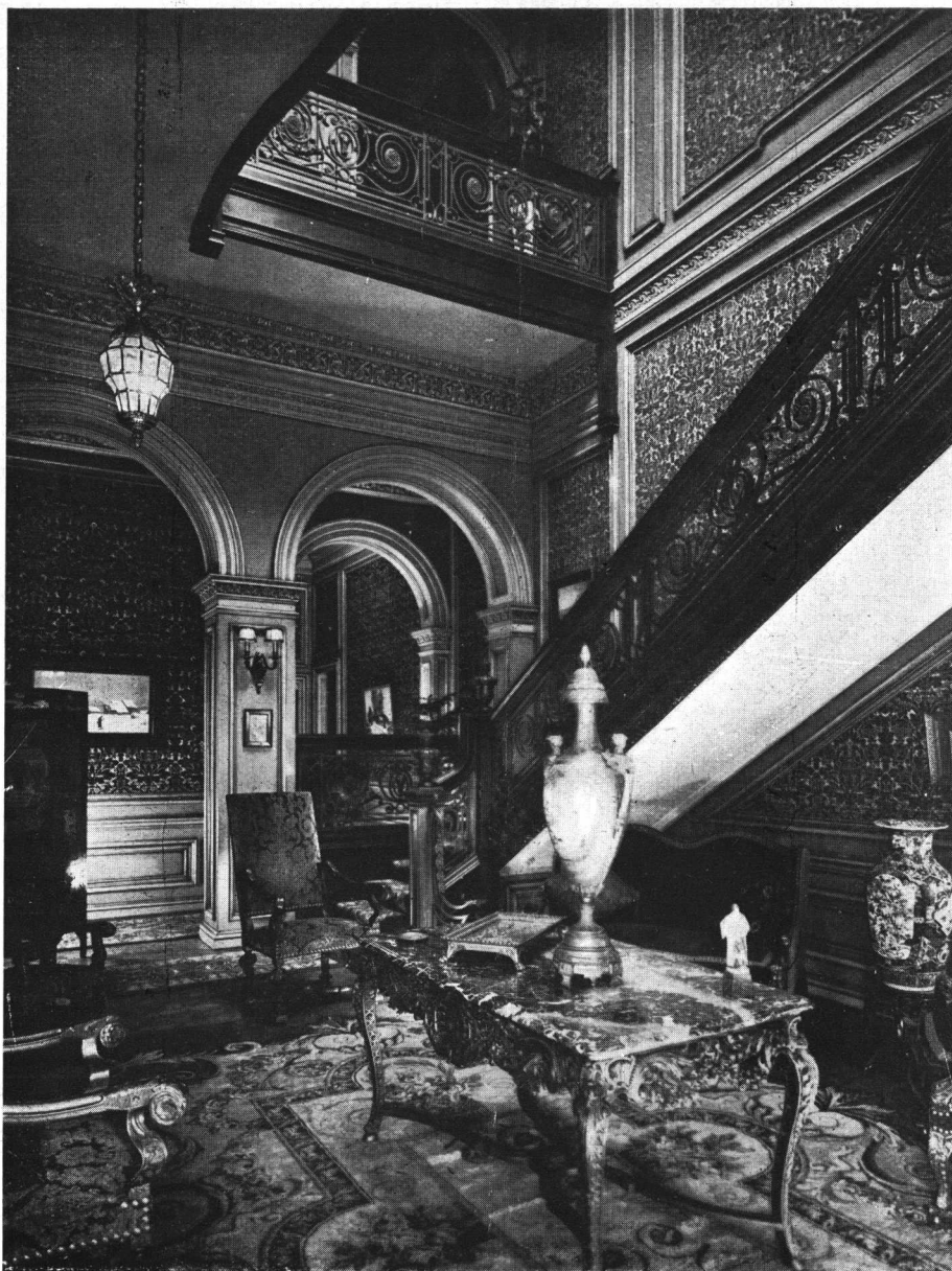
Proyecto y obra ejecutados por THOMPSON en la mansión del señor C. Sánchez Díaz.
