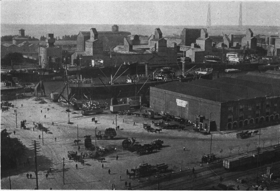
Dique No. 2 y Elevadores. Vista desde la calle Belgrano. * *
