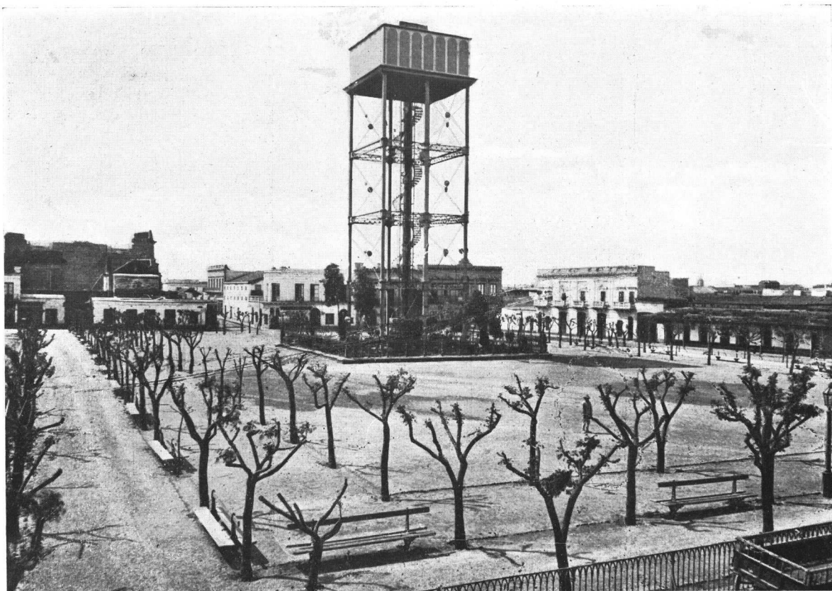
Plaza Lorea y tanque de aguas corrientes
