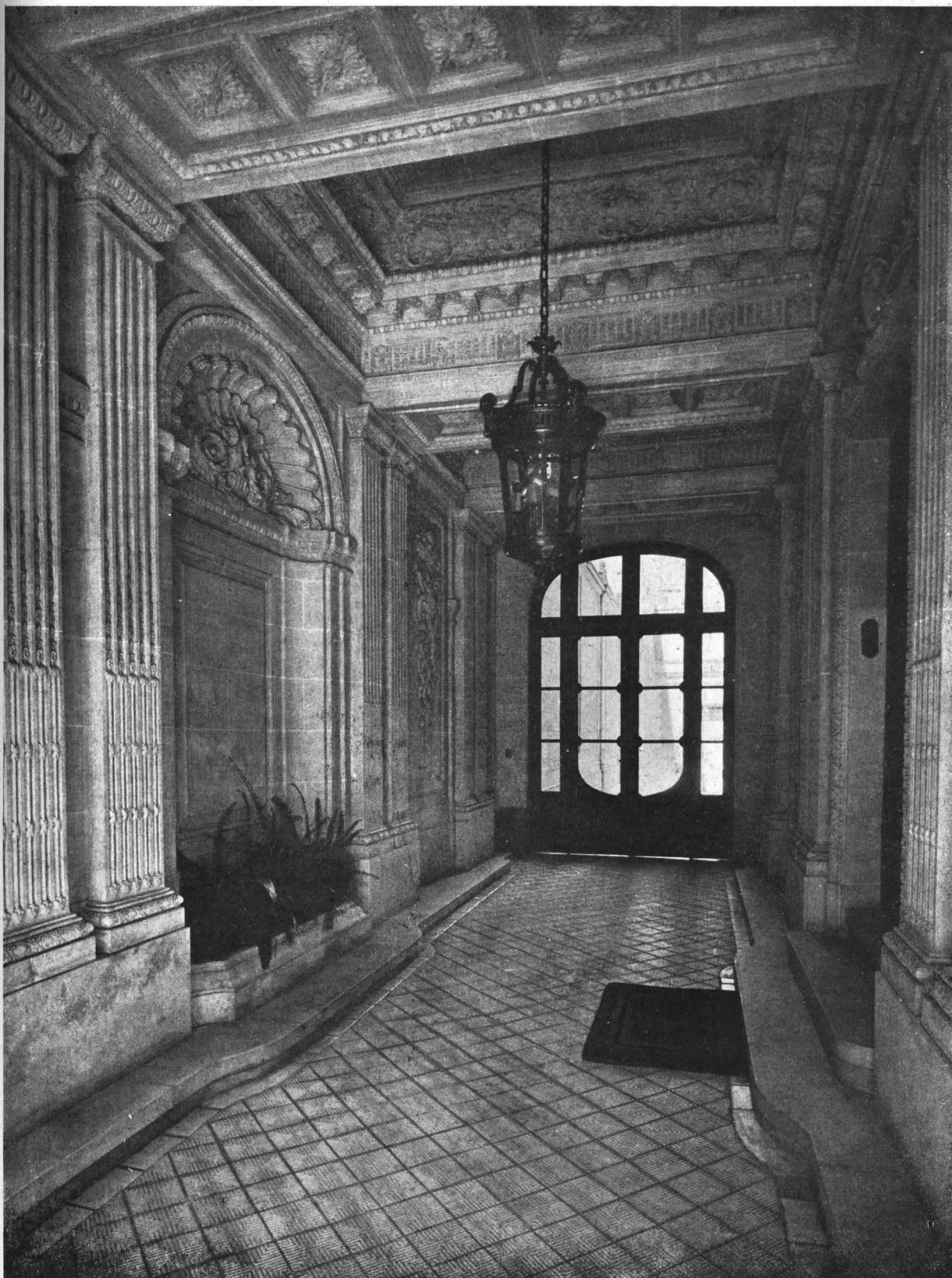
Detalle de la entrada principal
