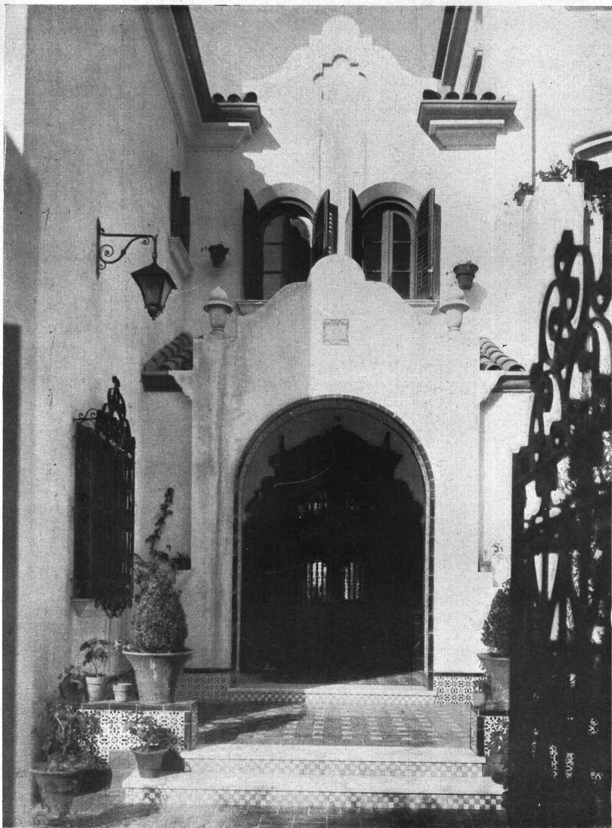
Pórtico de entrada .
