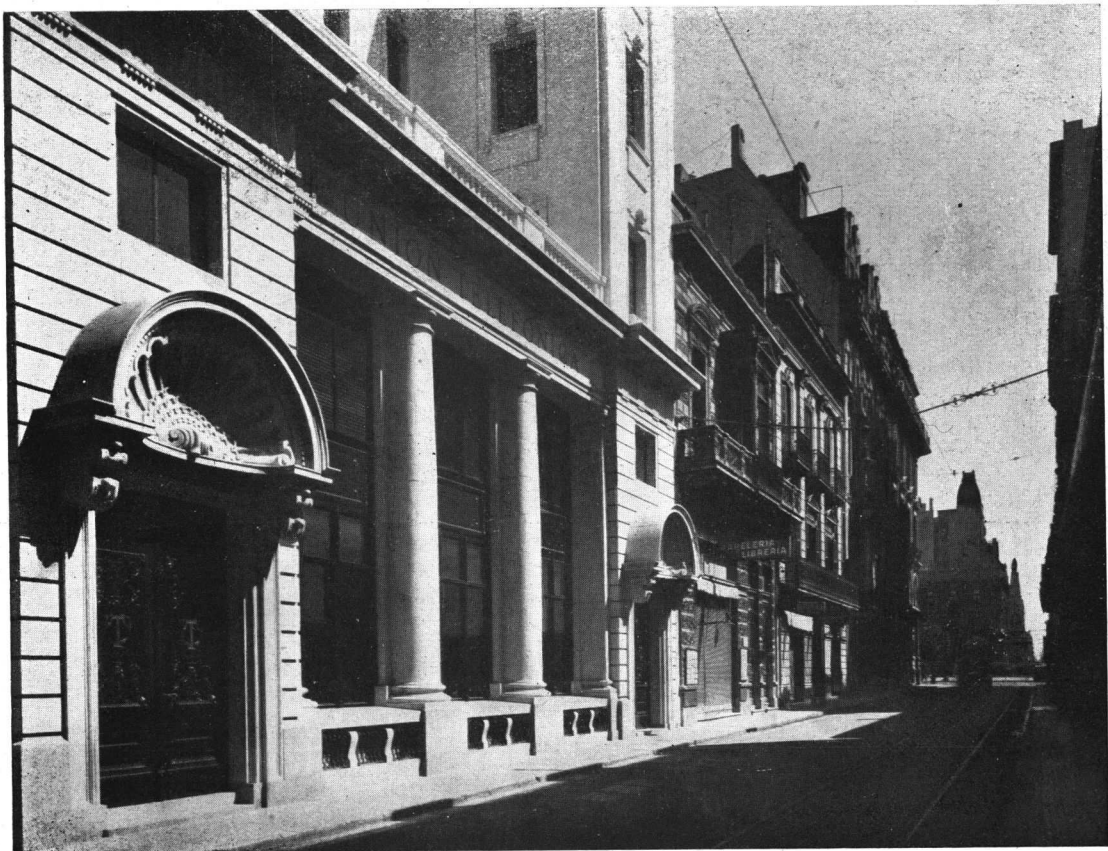
Compañía Unión Telefónica Arqs. Calvo, Jacobs y Giménez (S. C. de A.)
