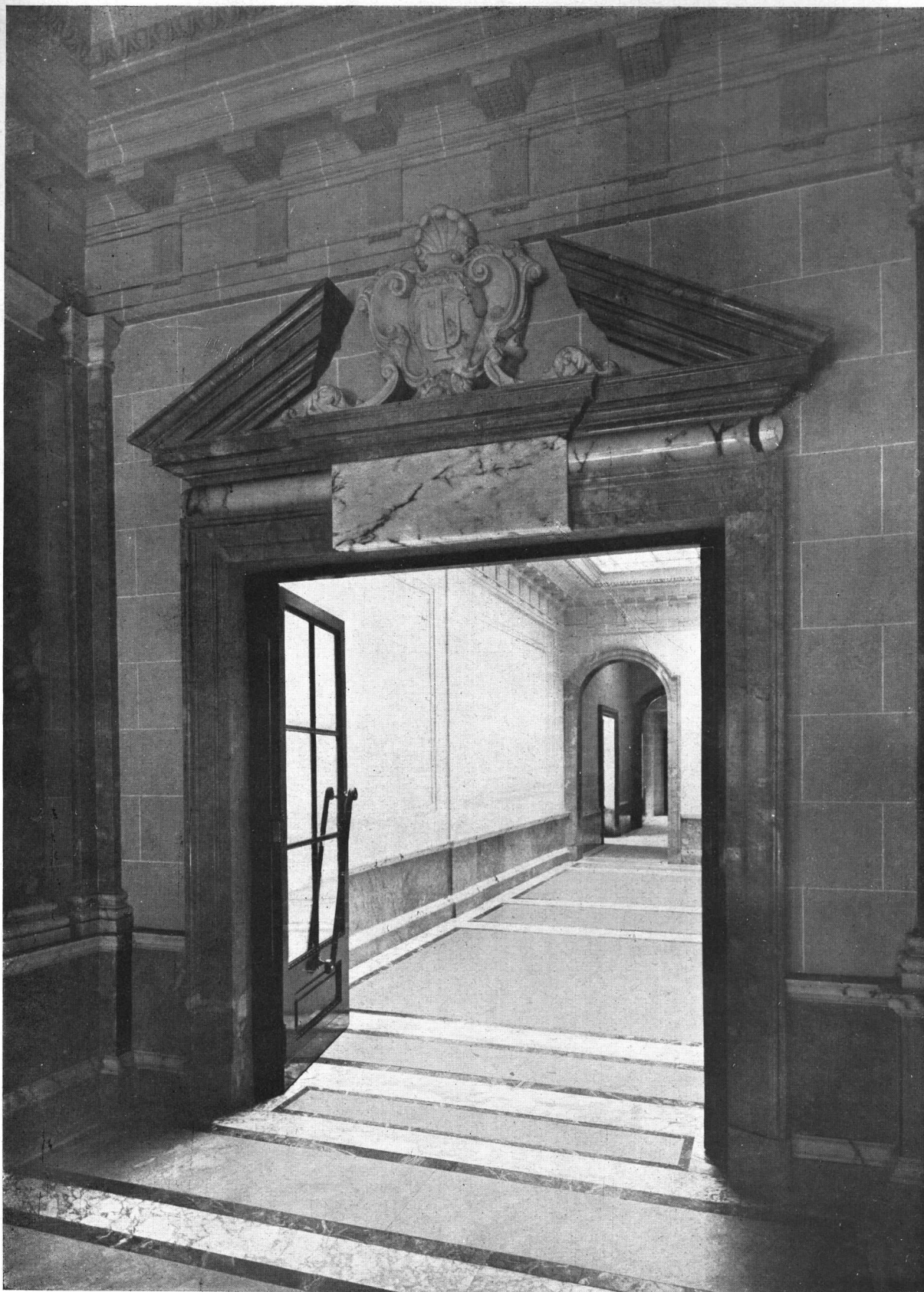
Compañía Unión Telefónica Arqs. Calvo, Jacobs y Giménez (S. C. de A.)
