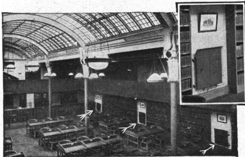
BIBLIOTECA: ilustrando su calefacción suministrada por RADIADORES MORGANITE.
