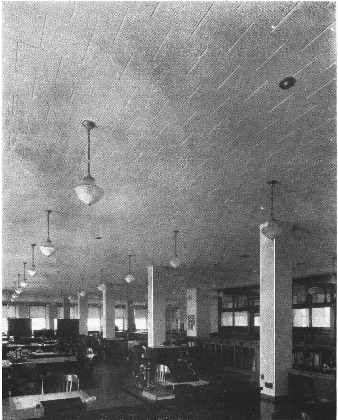
Oficina de Administración, Parke-Davis & Cía., Detroit, Michigan - Acousti-Celotex, tipo C. Arqs. Smith, Hinchmann & Grylls.
