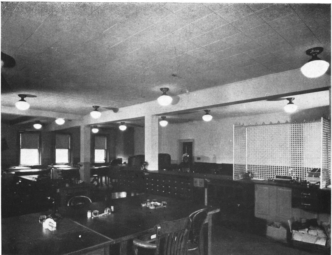
Oficina de The Cambridge Electric Light Co. Cambridge, Mass. Acousti - Celotex, tipo B.
