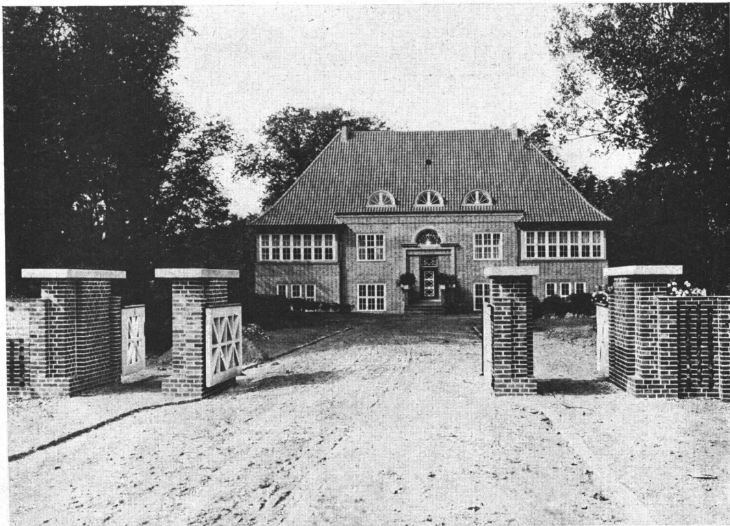
Edificio técnico para el mismo
