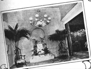
HALL de ENTRADA, ornamentado con una fuente de mármol de Carrara, de Strange.
