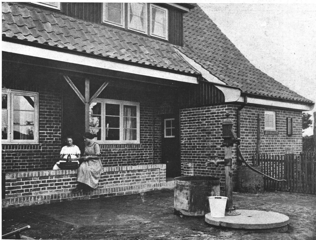
Detalle del patio de una de estas casas
