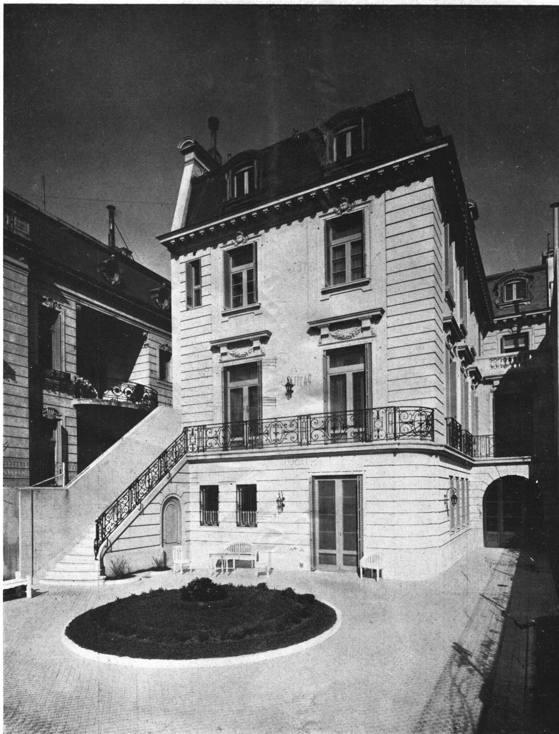
Vista del frente interior
