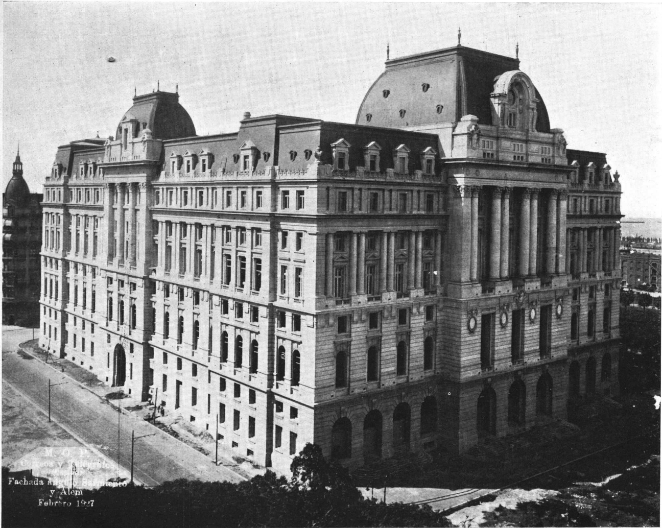
Casa Central de Correos y Telégrafos Vista de las fachadas, ángulo Avda. L. N. Alem y calle Sarmiento.
