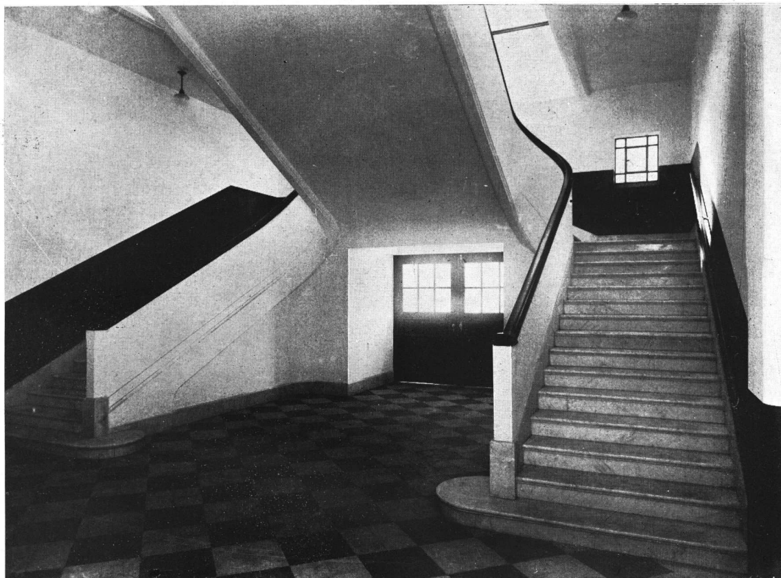
Arranque de la escalera a las aulas altas
