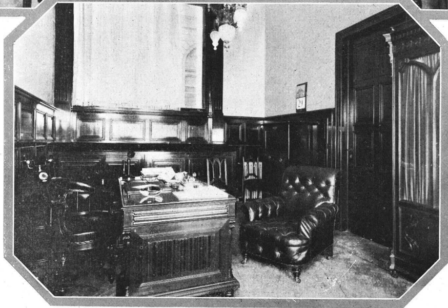
Banco Francés del Río de la Plata Vista de la Gerencia y Sub-Gerencia. Arquitecto. Jorge Bunge. (S. C. de A.)
