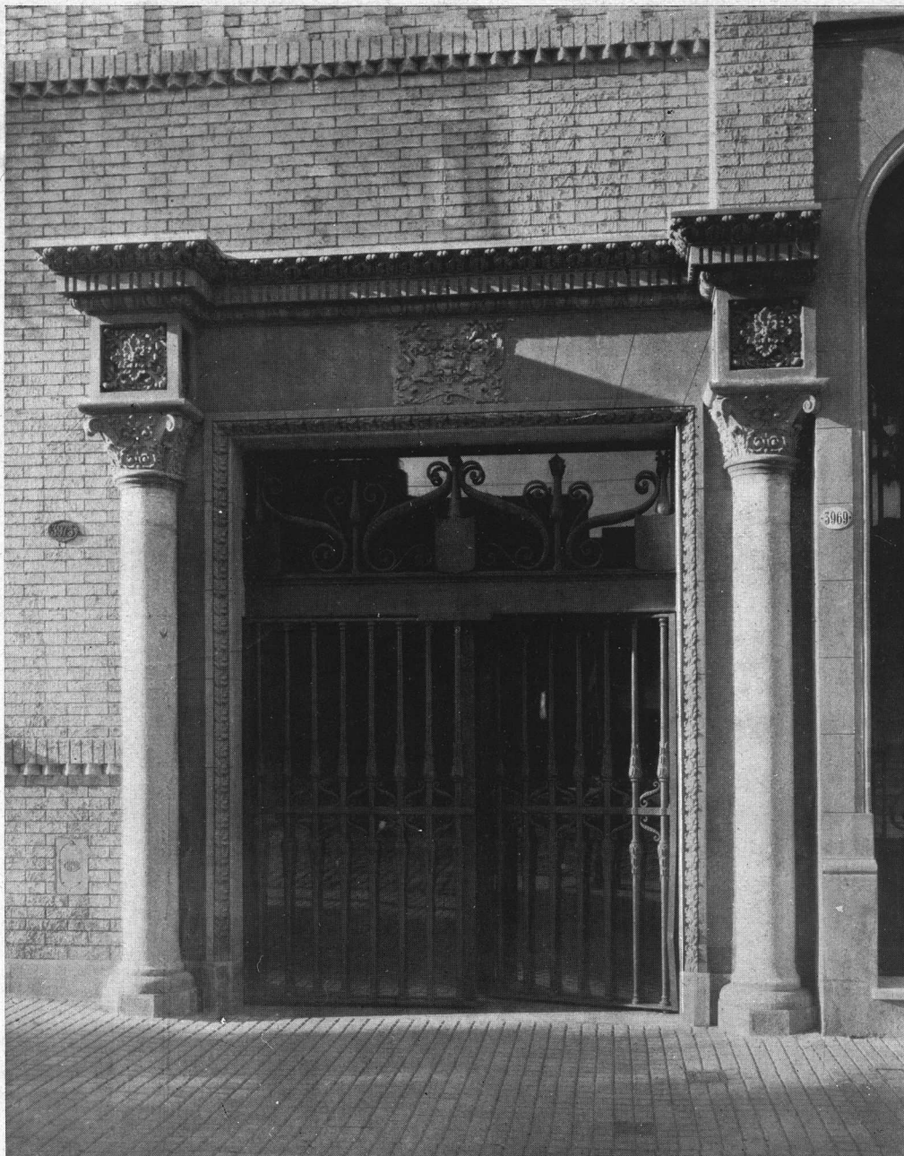
Puerta de entrada Principal
