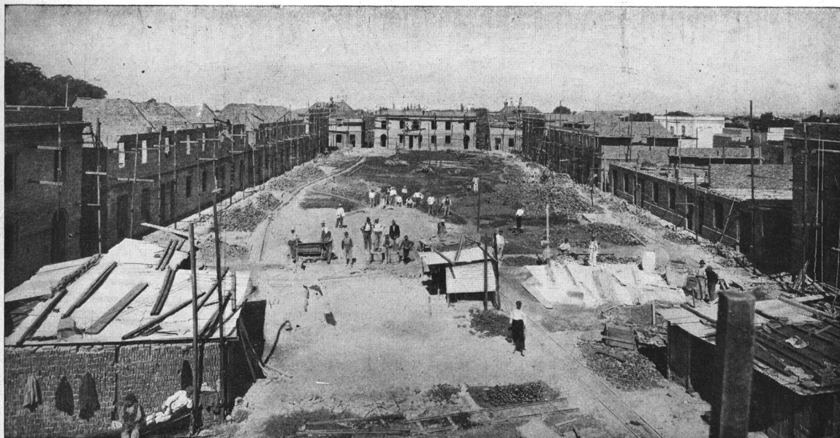
Vista interior de una de las Manzanas del Barrio M. T. de Alvear.
