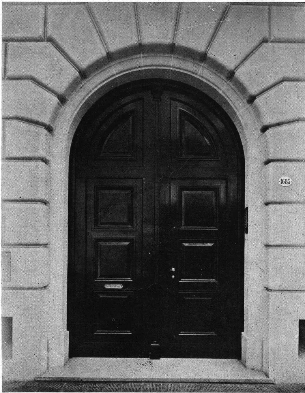
Puerta de Calle
