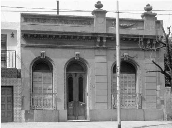
Casa Brigante-Hecker , la posición levemente excéntrica de la puerta se debe a que está en eje con la galería del patio
