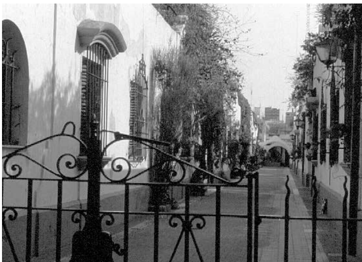
Pasaje . Arribeños 2364, Birabén Lacalle Alonso, 1928. El tratamiento del paso hacia las viviendas permite transformarlo virtualmente en una calle peatonal, llevando hasta cada una de las viviendas el privilegio del contacto con un espacio público
