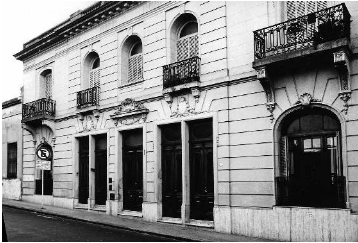
Fachada de Viviendas en hileras de Altos . Humberto I 637. Sobre la calle se multiplican las puertas, pues las viviendas sobre el frente, en planta baja y planta alta, tienen acceso independiente desde la calle.
