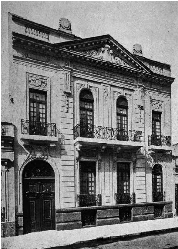
Hotel Camuyrano, Alfredo y Alberto Olivari, Viamonte 1856, Ca. 1921, fachada
