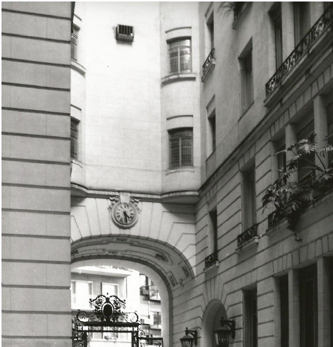
Edificio Estrugamou en Arroyo y Esmeralda (Sauze y Huguier, 1929)
