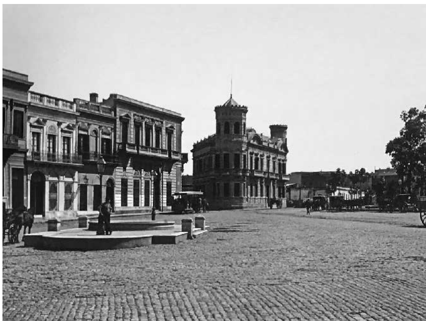
Buenos Aires, Plaza de Toros, hoy Plaza San Martín. Se destaca el edificio, que reformado, hoy ocupa Parques Nacionales. Alrededor de 1890
