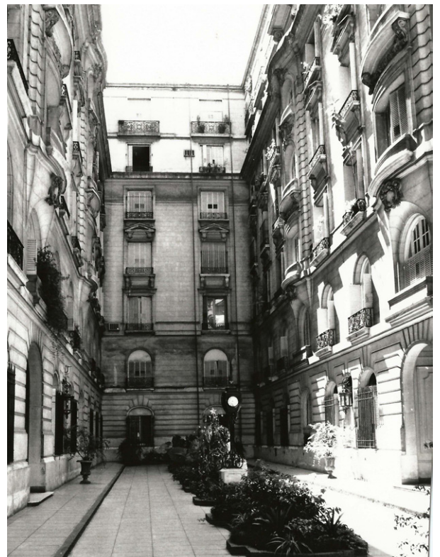
Edificio en "cour d'honneur" en Ugarteche y Cabello, conocido como el "Palacio de los Patos", (Azière, Senillosa, 1929).
