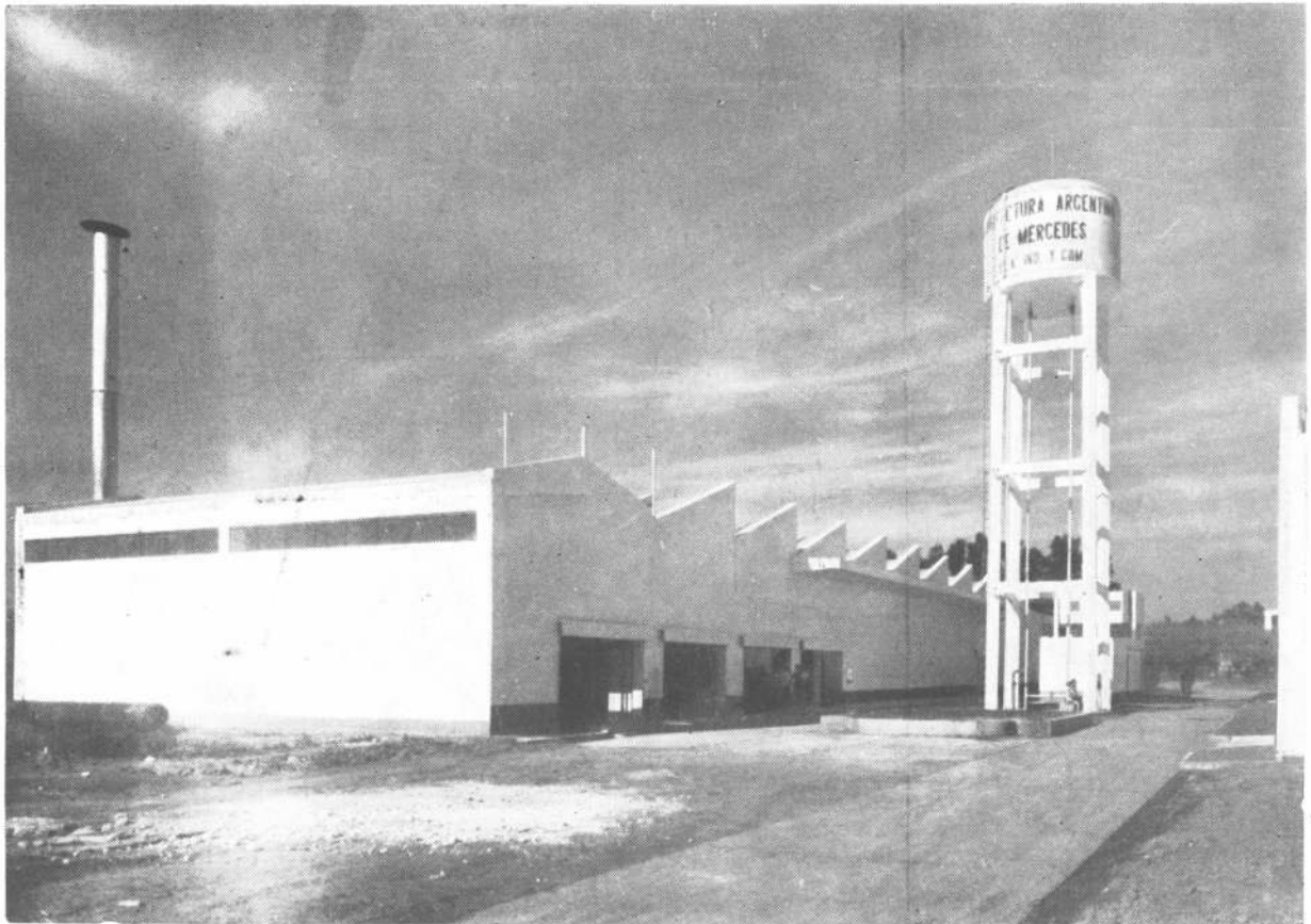
Parte trasera de la fábrica con el pabellón de la Central Térmica y vista del tanque para agua.
