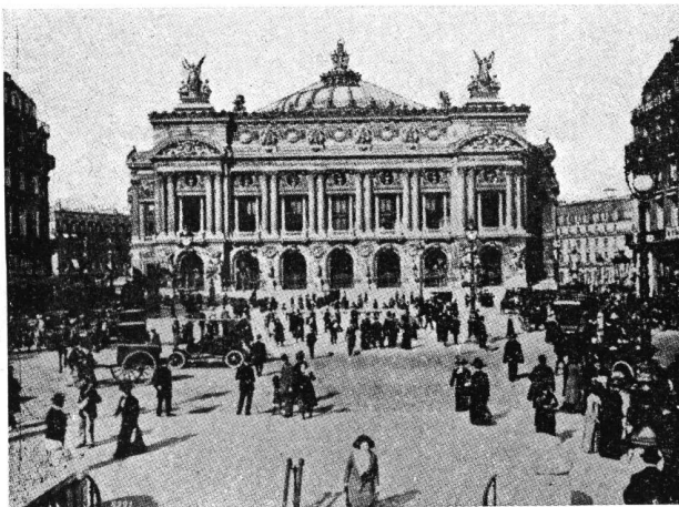
29. Fachada principal de la Opera frente a la plaza y avenida del mismo nombre
