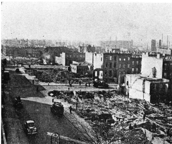
17. Demoliciones realizadas para el ensanche de Hicks Street, Brooklyn, N. Y.
