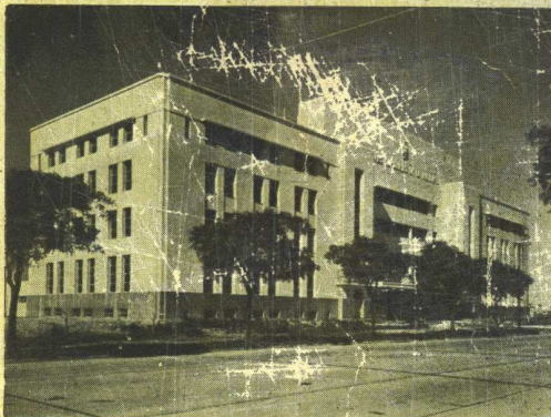
OBRAS SANITARIAS DE LA NACION Edificio Avda. Centenario
