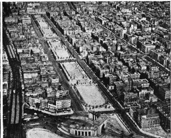
14. Parque Roosevelt, zonas de juegos y gimnasia realizado en el terreno desocupado por caseríos demolidos en el bajo Manhattan.
