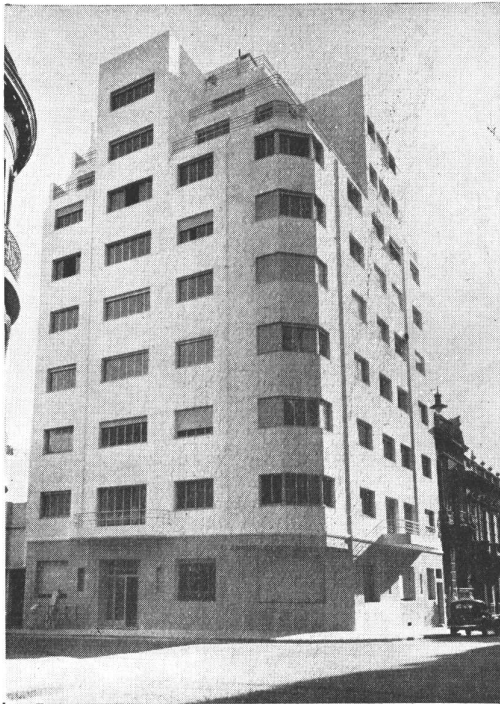
Edificio de Renta, Calle LARREA esq. ARENALES Ingeniero: LUIS V. MIGONE Instalador Sanitario: FELIX A. SANTORO
