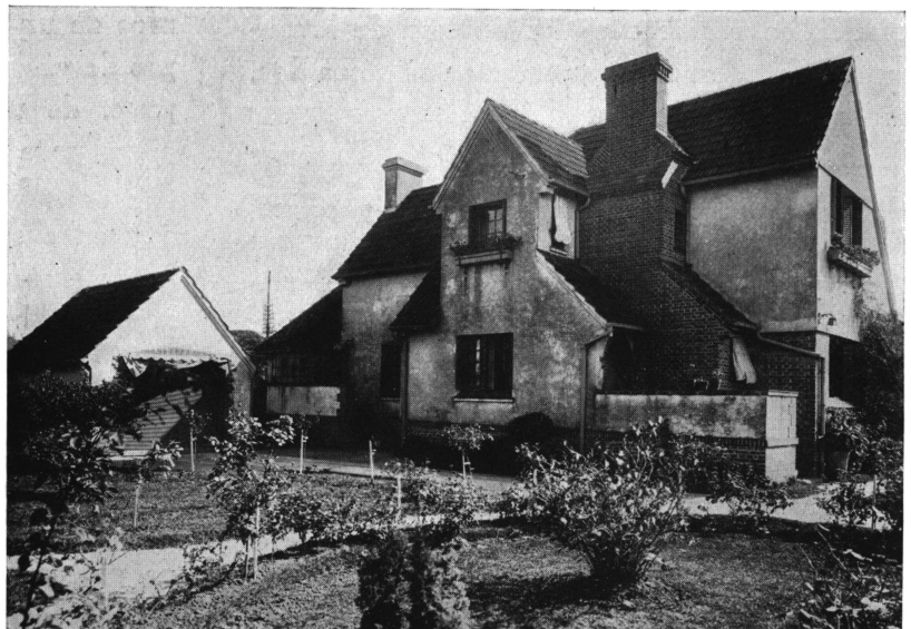
Arriba: Fachadas al Norte y Este Abajo: Fachada posterior
