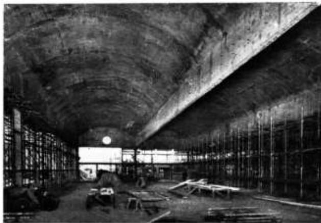
Fig. 5. — VIGA DEL GARAGE DE BOURNEMOUTH. Salto en el espacio de una forma rectilínea sin paralelo.
