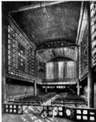
Fig. 8. — SANTA TERESA EN MONTMAGNY. Junto a la anterior constituyen exponentes de una verdadera arquitectura del hogar.
