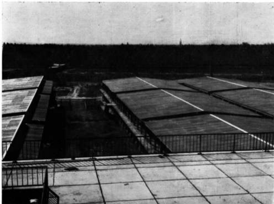
Vista del Block Industrial tomada desde la azotea del Block de Enseñanza e Investigación. Hacia la derecha, la Bodega Experimental y Fábrica de Aceite. Hacia la izquierda, los Institutos Tecnológicos de la Madera; en el centro, patio central de trabajos del Block Industrial.
