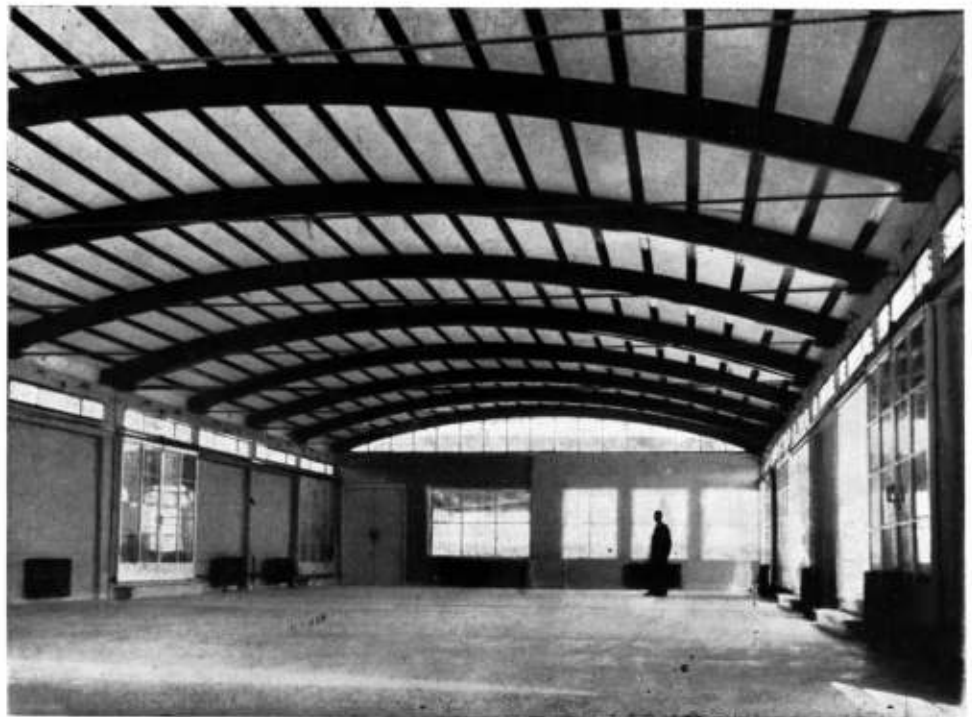
Interior del Salón del Club Universitario. — Cielorraso de arcos de madera laminada con tensor de hierro. Cubierta de aislante 7 cm. de espesor y placas de aluminio. Sus condiciones de aislación resultaron más eficaces de las previstas.
