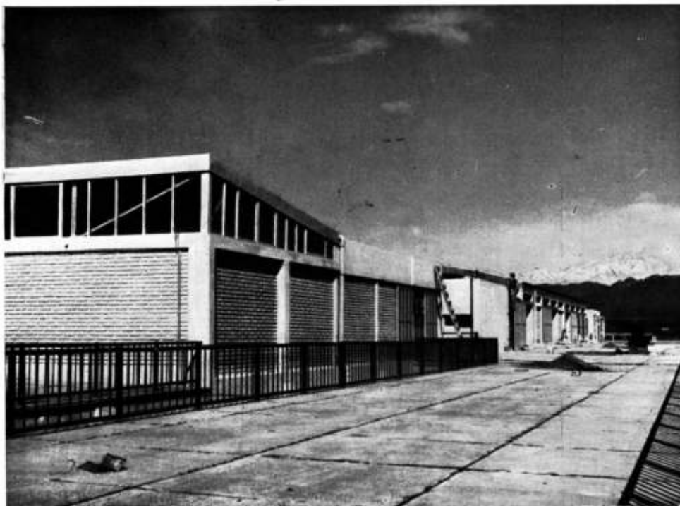
Planta de azotea de 3.000 m 2 , con las dependencias para la filial del Club Universitario. Desde esta azotea se domina una amplia vista panorámica de la región Chacras de Coria, Departamento de Luján, y de los cerros que constituyen la cordillera a la altura de la latitud 33° S.
