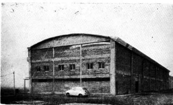
El interior de la nueva fábrica tomado de norte a sur (arriba) y de sur a norte (al centro). El exterior desde la entrada (norte).
