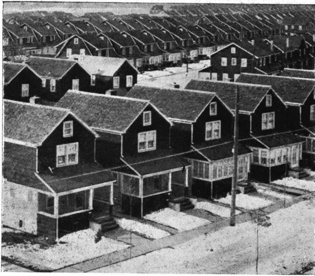
La actual producción en serie en manos de constructores especuladores. El deterioro de las viviendas es muy rápido.
