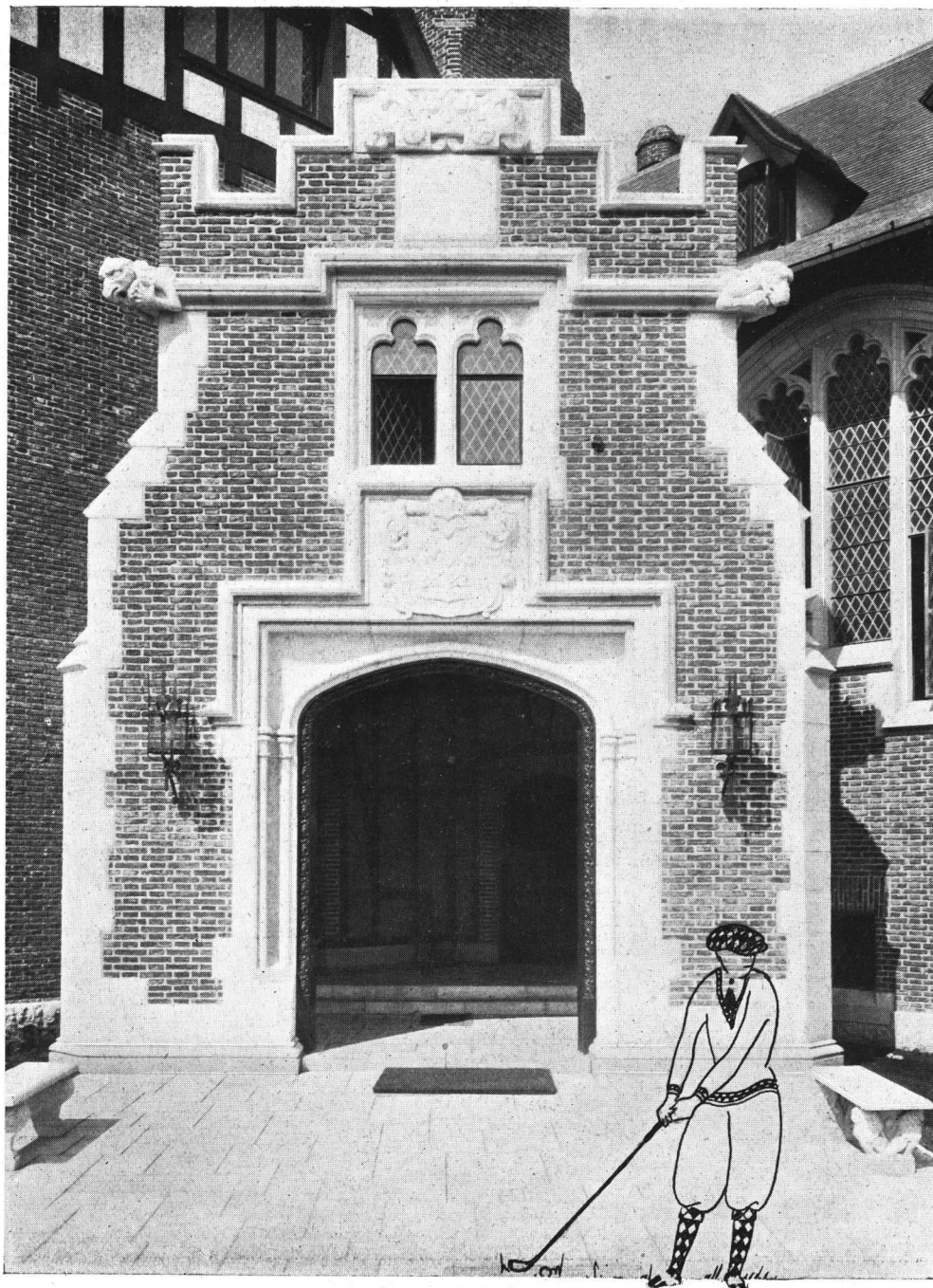
Detalle exterior del Porch
