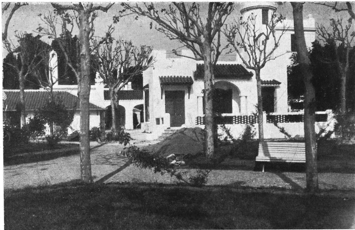
Fachada sobre la barranca
