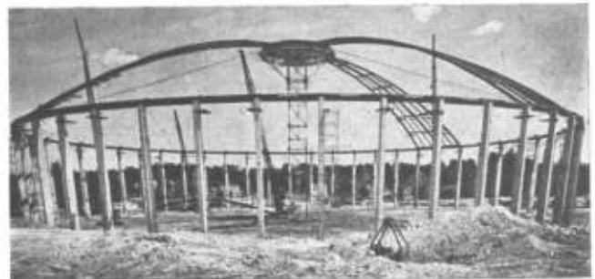
Las secciones de arco de 50 metros, fueron armadas en el terreno y colocadas tres a la vez por cuadrante, de manera de evitar presiones desiguales en el arco de tensión y en las columnas.
