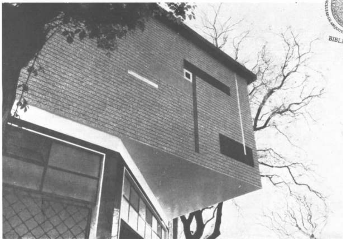
Frente en chapitas de cm. 6x24 y panel decorativo en el mismo material. Mariano Acosta y Directorio
