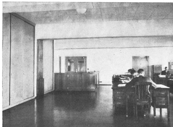
Parte de un local de oficinas en el primer piso.
