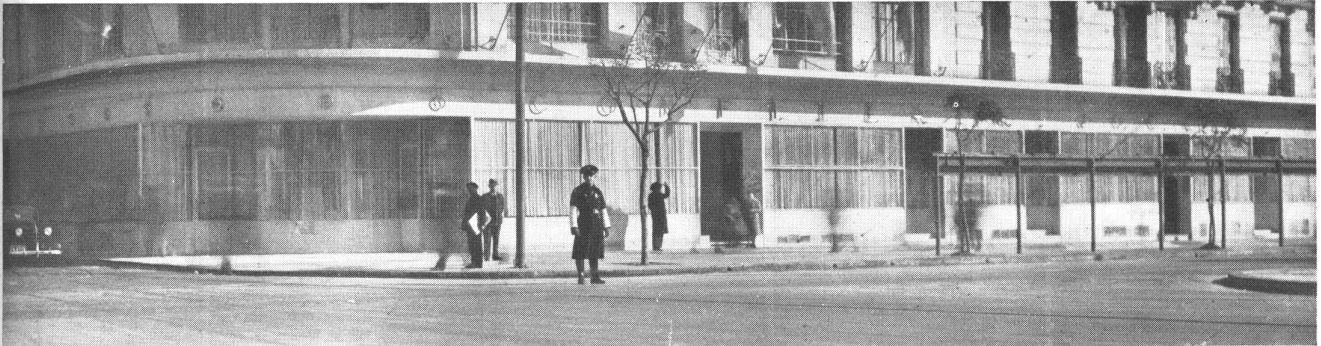
Vista parcial del exterior.
