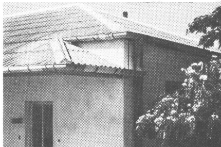
Chapas onduladas rectas de onda chica y grande, en colores gris, rojo y crema.
