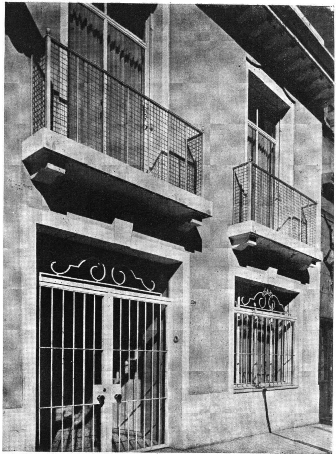
DETALLE DE LA ENTRADA PRINCIPAL
