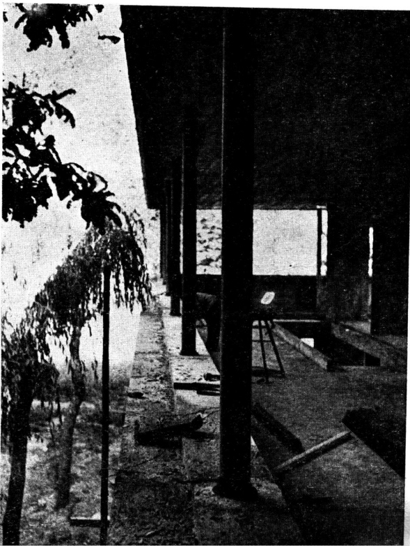
La planta alta ya desencofrada.
