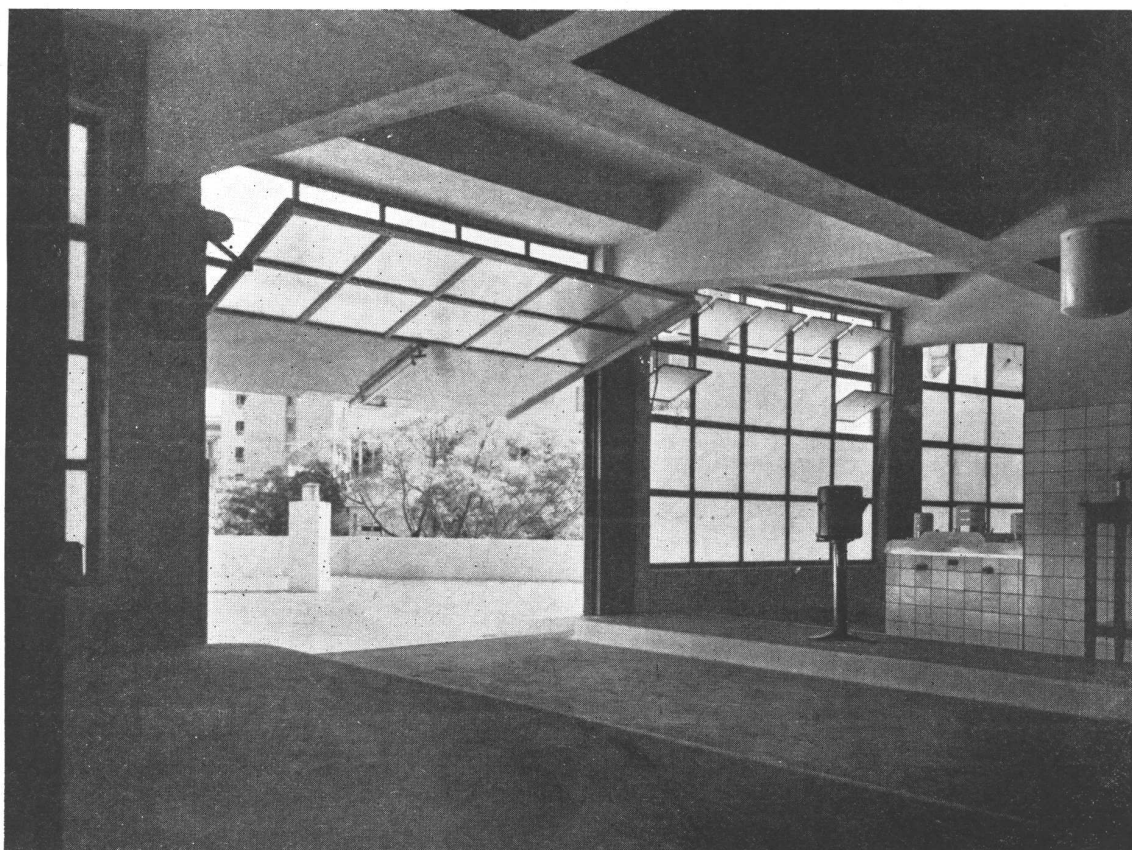
Tres fotografías en que se aprecia la aplicación de las puertas Relámpago sistema Wanner. En la de arriba a la derecha, se ve la playa de maniobras y estacionamiento en el 5º piso, que sirve de comunicación entre las dos rampas helicoidales de acceso desde la planta baja a todos los pisos.
