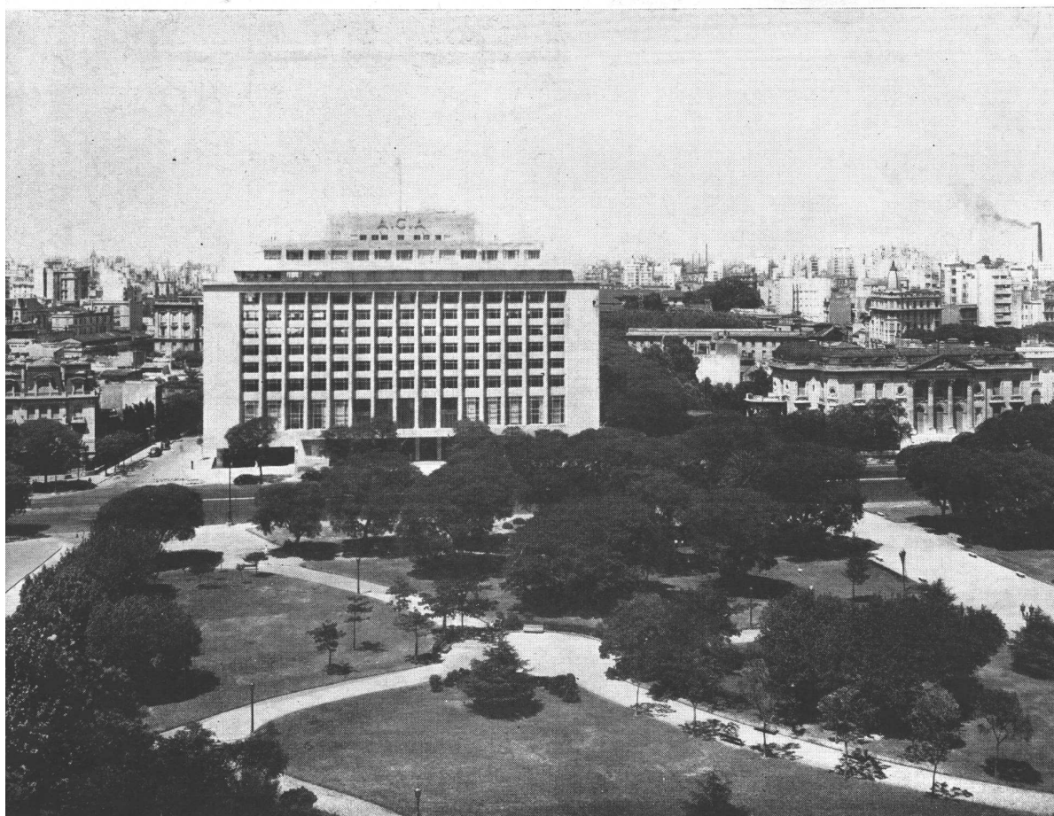
Vista del edificio desde una casa de departamentos próxima. Puede verse el desorden de la edificación circundante (característica de toda gran ciudad contemporánea) a que se refiere el escrito adjunto.
