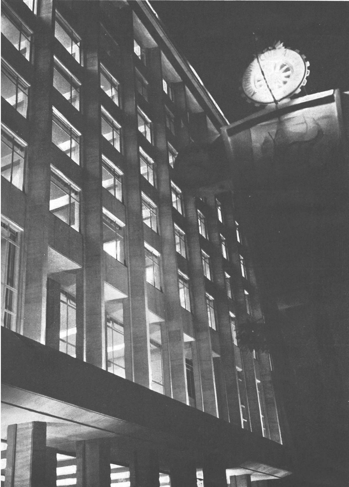
Detalle nocturno de la fachada.
