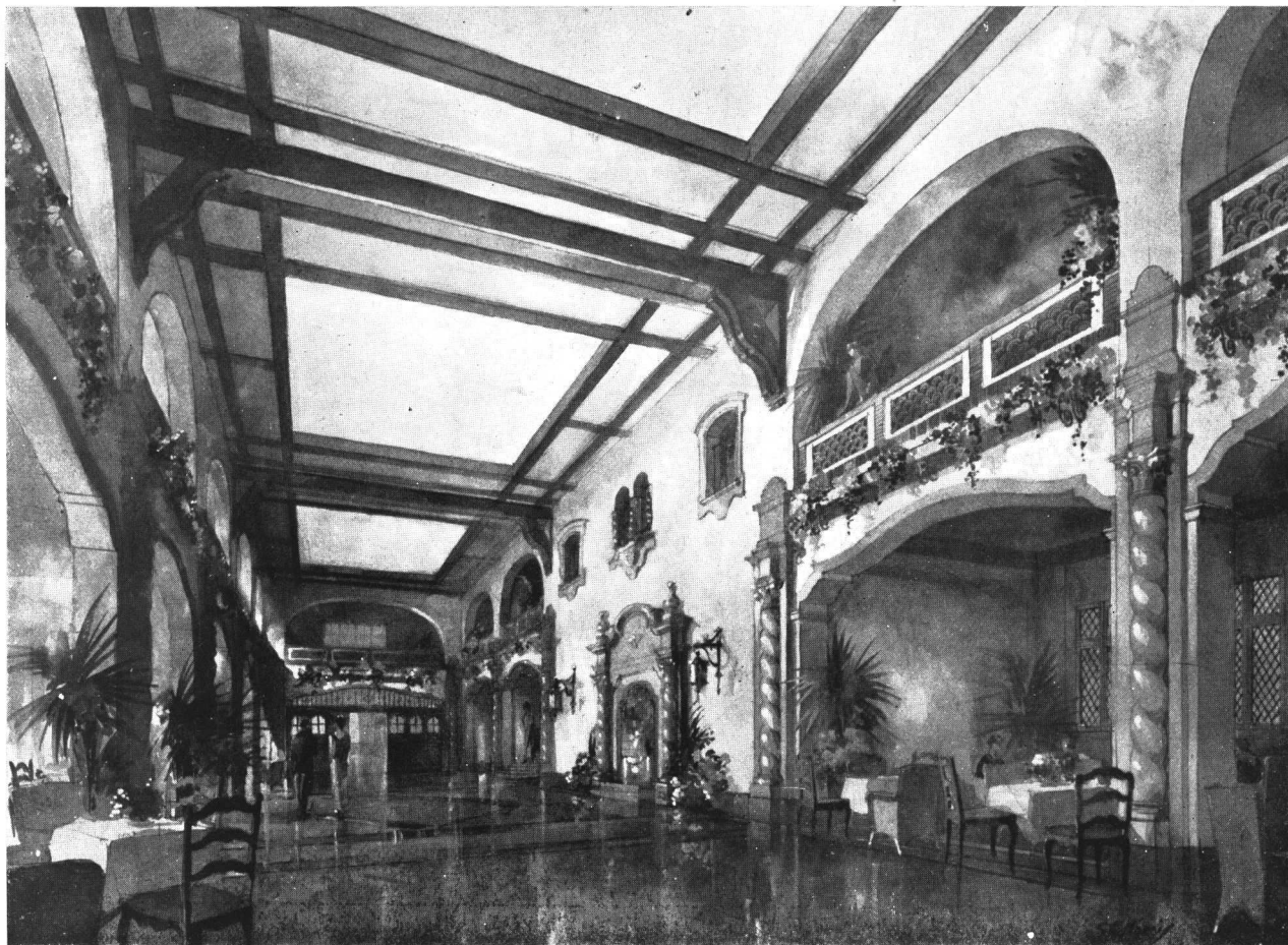
Perspectiva del Roof Garden, Restaurant, en ejecución
