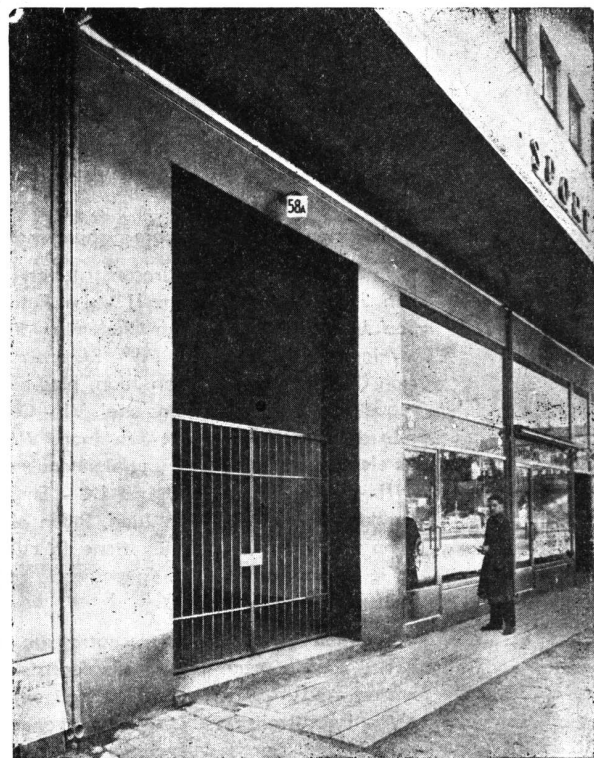
Revestimiento de frente en acero inoxidable en un establecimiento comercial en Estocolmo.
