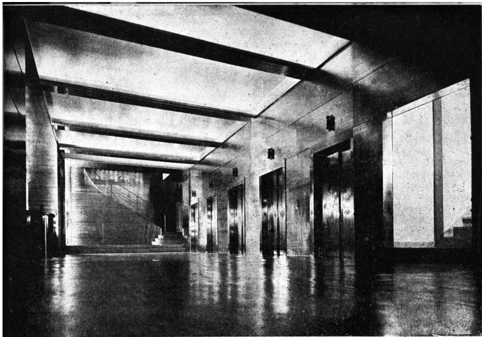
Revestimiento de frente en acero inoxidable en un establecimiento comercial en Estocolmo.
