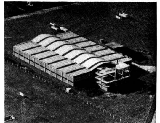
Planta industrial de la Empresa Romapar, ubicada a la altura del Km. 21 de la Ruta Panamericana.
