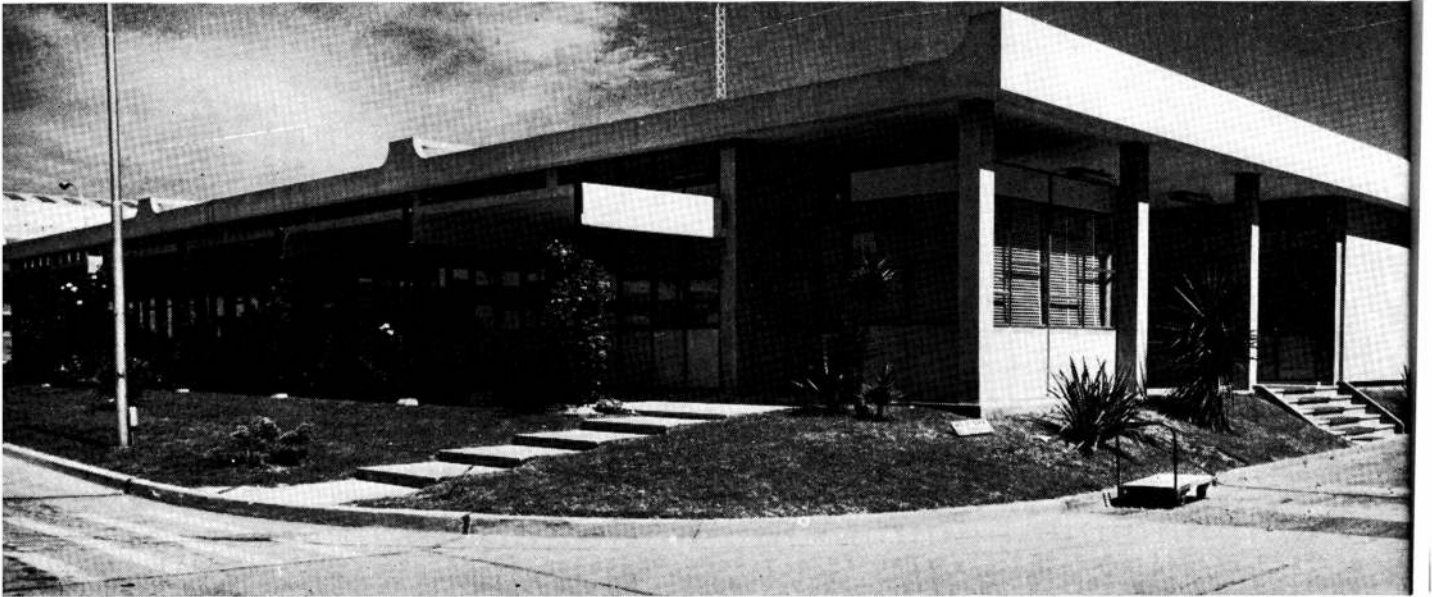
Edificio de Servicios Sociales y vestuarios.
