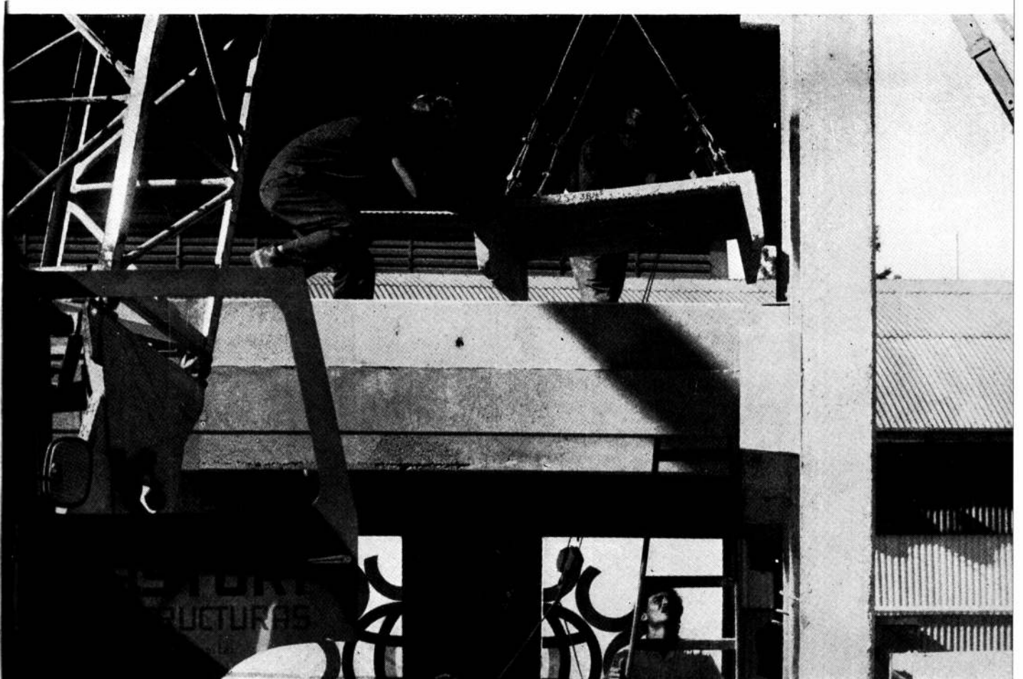
Detalle colocación losetas del entresiso.
