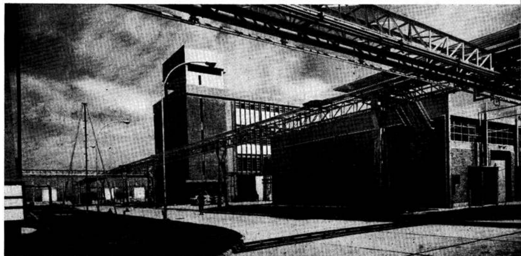
En primer plano edificio para almacenamiento de vehículos; al fondo planta de fabricación de resinas sintéticas. Puede apreciarse la solución que se dió a los cruces de cañerías. Los tendidos paralelos a la calle principal lo hacen por la parte superior de la viga, los transversales por la parte inferior.
