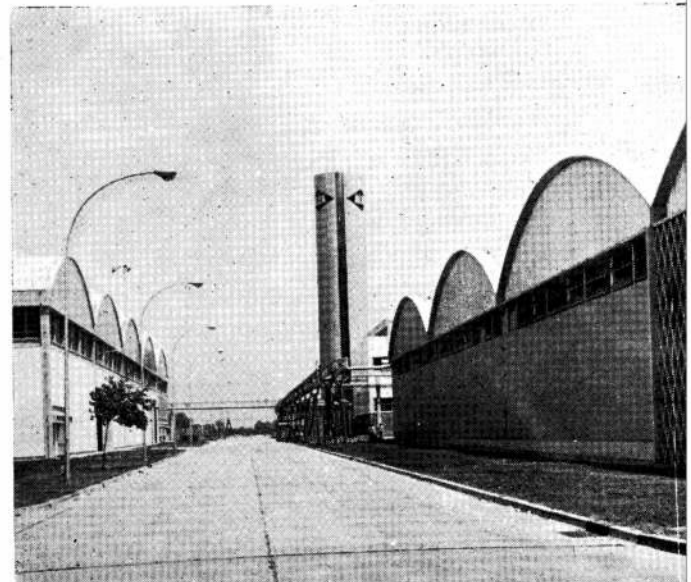
Calle principal; a la derecha el edificio de Depósito de Productos Terminados. El reticulado de hormigón armado disimula las ventanas que hay en dicho sector, correspondientes a las oficinas administrativas de despacho de mercaderías.
