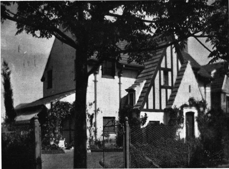
Detalle de fachada
