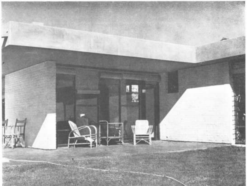
Vista de la terraza exterior.
