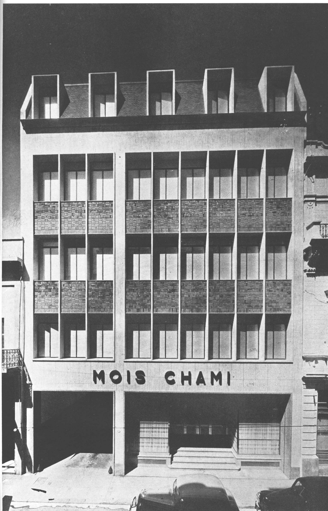
Fachada; ventanas a pivot vertical y banderolas, vidrios termolux, revestimiento de travertino y granito rosado de San Luis, paredes de ladrillo prensado. Vidrieras y entrada de bronce.
