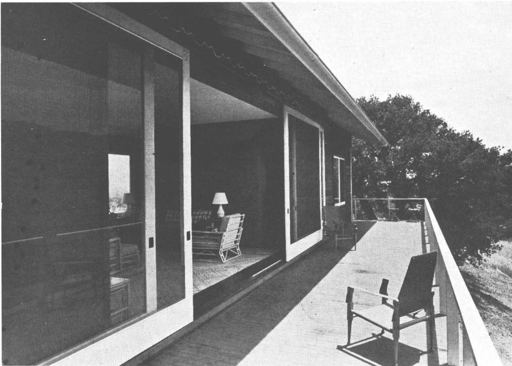
Grandes puertas y persianas corredizas abren completamente el living room hacia el balcón-terraza y las vistas que se ofrecen más allá.
