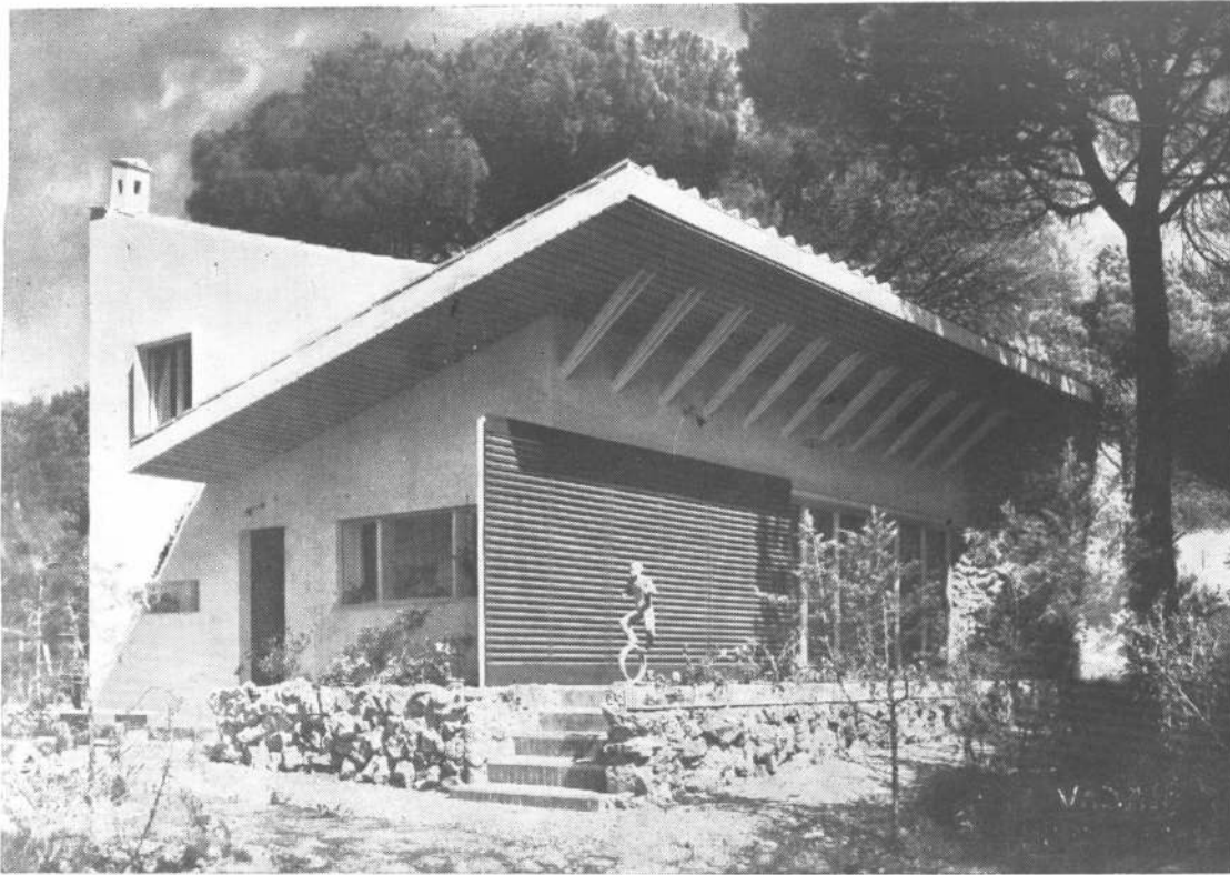
Vista desde el jardín. A la izquierda la entrada de servicio. Al frente la gran persiana corrediza que cierra de noche la parte vidriada del living room.
