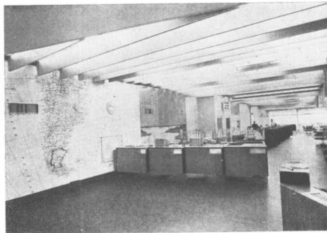
Salón de Operaciones, con Aire Acondicionado Carrier, sistema Fan-Coil
