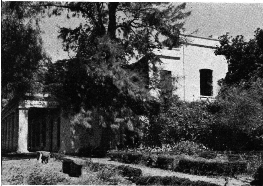
FACHADA LATERAL SOBRE EL JARDIN
