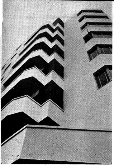
FACHADA SOBRE LAS HERAS y OCHAVA
