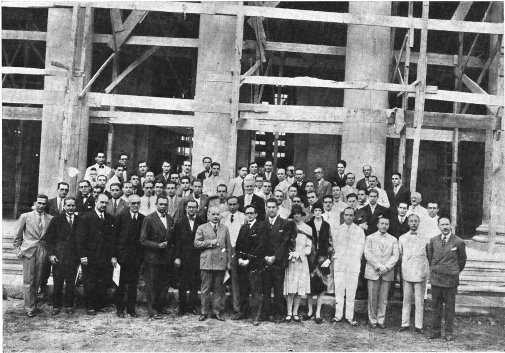
Visita de las Delegaciones a obras públicas
