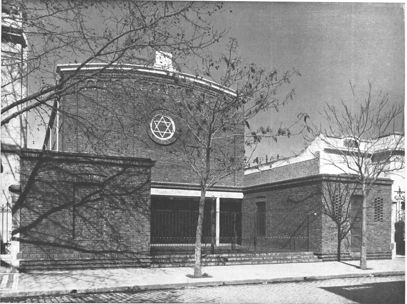
Otra vista del frente. En primer plano la Secretaría y Biblioteca y la vivienda del portero.
