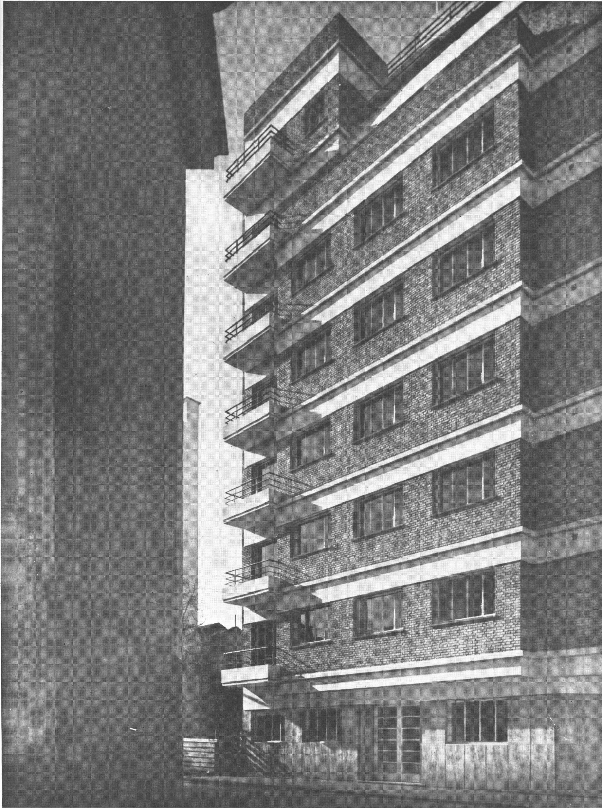
STOK Y STOK, ING. CIV. Y ARQ. Casa de departamentos: la fachada sobre la calle Arenales.
