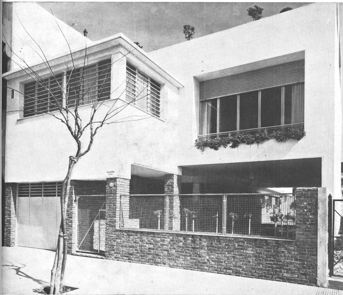
La fachada de la casa situada en la calle Tagle 2972 propiedad de la Sra. Angela K. M. de Aranovich.
